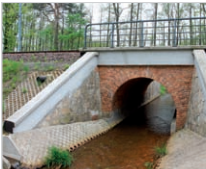
RYC. 19. ZABUDOWA HYDROTECHNICZNA CIEKÓW STANOWI PRZESKODĘ W PRZEMIESZCZANIU SIĘ BOBRÓW. Fot. Waldemar Bena
