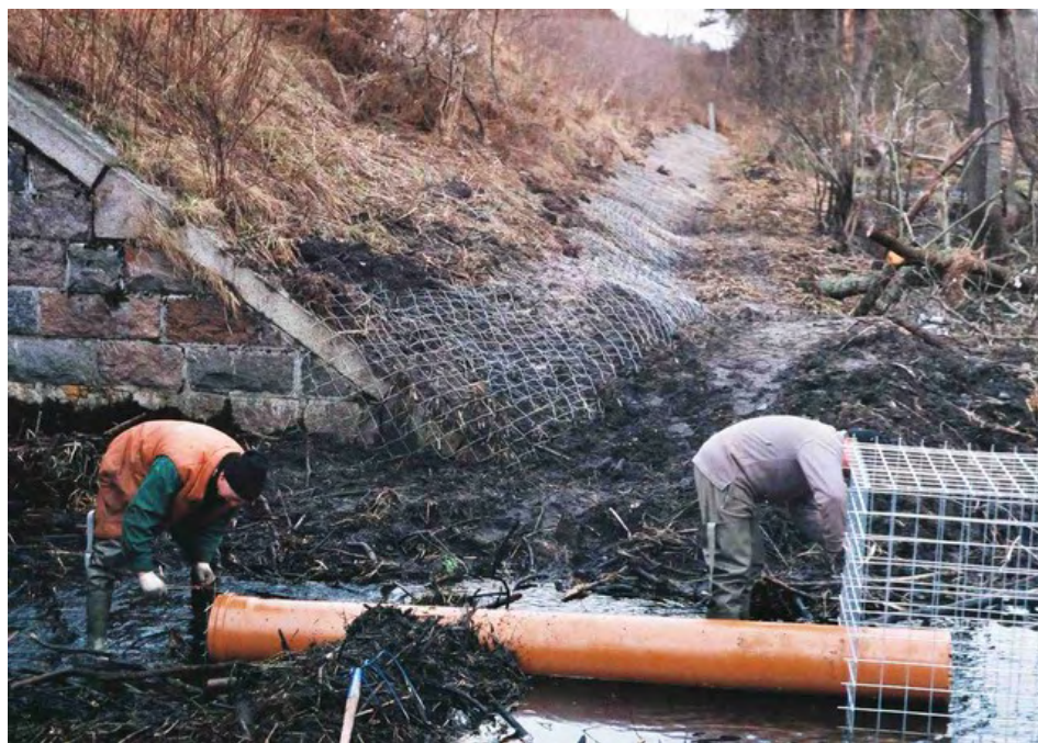
Ryc 9. Kompleksowe zabezpieczenie przepustu pod nasypem kolejowym i samego nasypu. Fot. Albert Zabielski
