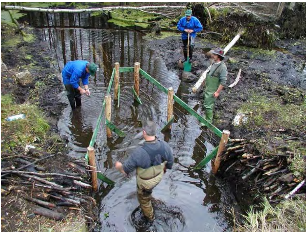
Ryc 8. Montaż ogrodzenia zabezpieczającego przepust w okolicach Supraśla. Fot. Agnieszka Łopata.
